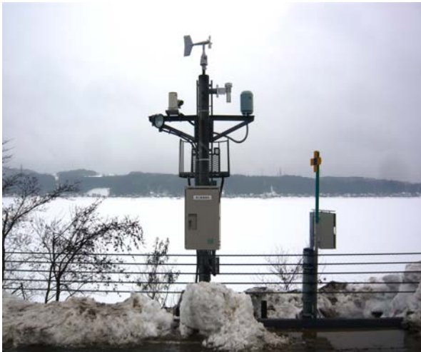
気象観測機器設置工事
