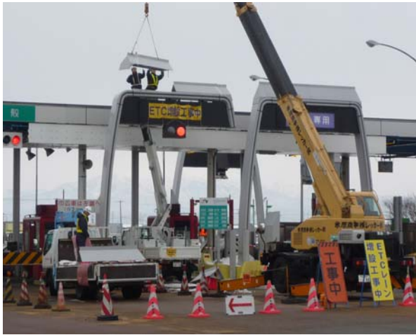
ETCレーン増設工事
