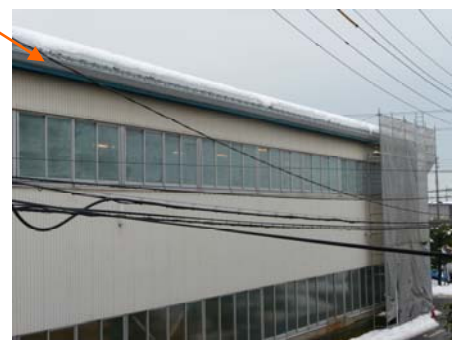
工事後 工場外観
