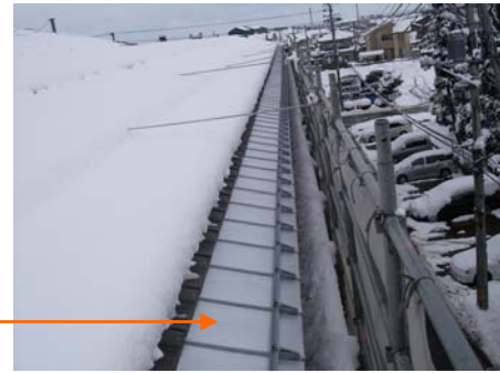
ルーフヒーター工事後
