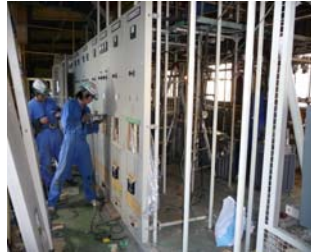
T社変電室 VCB 取付作業
