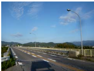
国道7号線 加治大橋 水銀灯 400W
