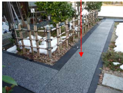
敷設状況(ゴムシートの上に敷設)
