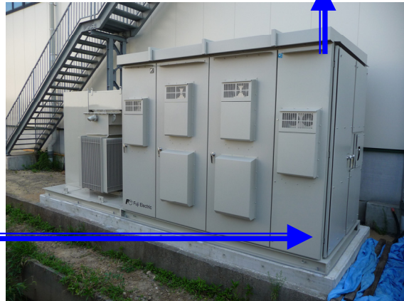
パワーコンディショナー(直流を交流に変換)
