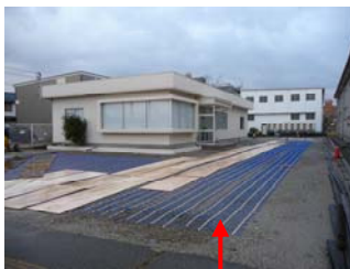
ヒーター敷設 51kw | 253 m 2
