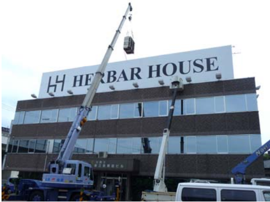
K社テナントビル 屋上室外機撤去
