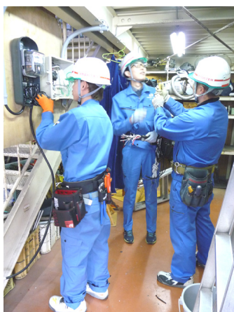
メーター取付工事
