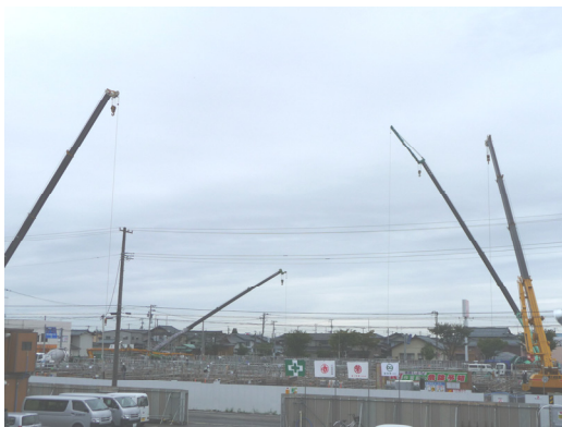
工事現場(旧体育館跡地)
