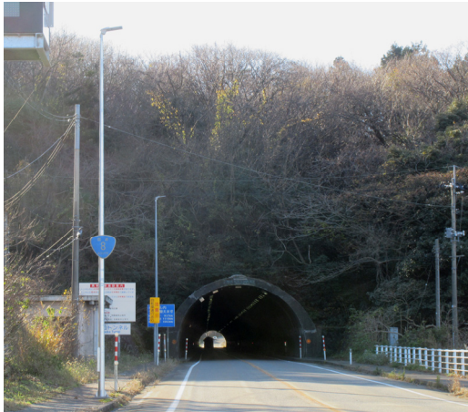
芭蕉が丘トンネル(柏崎市) トンネル照明と坑口照明
