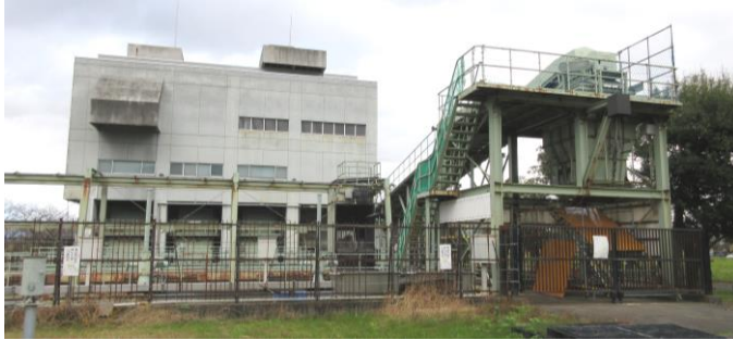
雨水ポンプ場(三条市塚野目)
